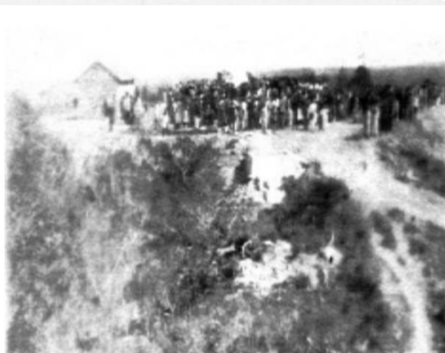
1923 – parte alta do morro de Capão Bonito – já aplainado para iniciar a construção.
