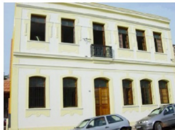
Prédio que já abrigou o Fórum Trabalhista foi reformado
